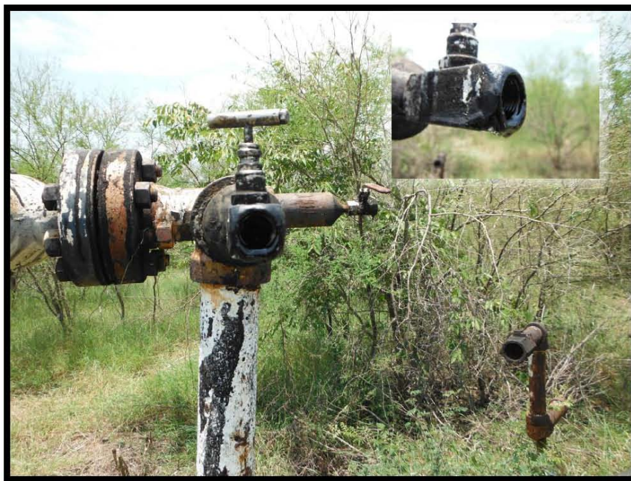
Fotografía 7.- Presenta filtración y falta de tapones de ½" en válvula tipo aguja, falta de tapón roscado en tubería de bajante.
