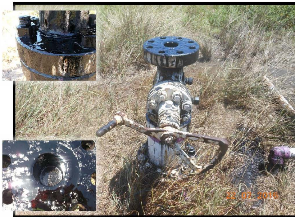
Fotografía 4.- Falta de brida y capuchón en válvula de sondeo, válvulas del cabezal de la tubería de revestimiento enterradas, no cuenta con contrapozo, falta de esparrago en conexión bridada de válvula de sondeo, árbol de válvulas con manchas de hidrocarburo.
