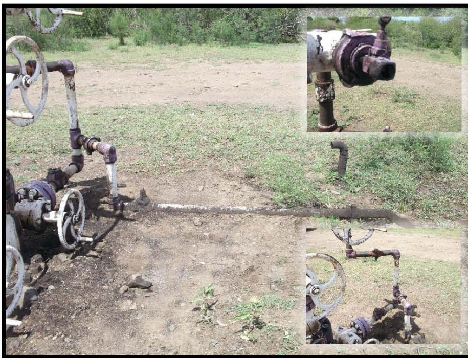
Fotografía 5.- Corrosión y manchas de hidrocarburo, falta de: tapón de 1/2 " en válvula tipo aguja, de mochetas y abrazaderas, no cuenta con barandal de protección en bajante de producción; tubería expuesta sin tapón a un costado de línea de recolección.
