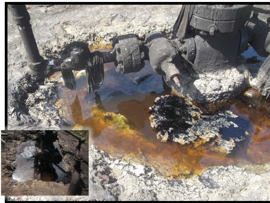
Fotografía 6.- Agua con trazas de hidrocarburo en periferia del árbol de válvulas, no cuenta con contrapozo, hidrocarburo intemperizado en periferia del árbol de válvulas.
