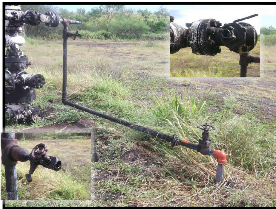
Fotografía 6.- Falta de Barandal de protección en bajante de producción, corrosión y manchas de hidrocarburo, falta de tapones de \frac{1}{2} " en válvula tipo aguja de porta estrangulador y bajante de producción
