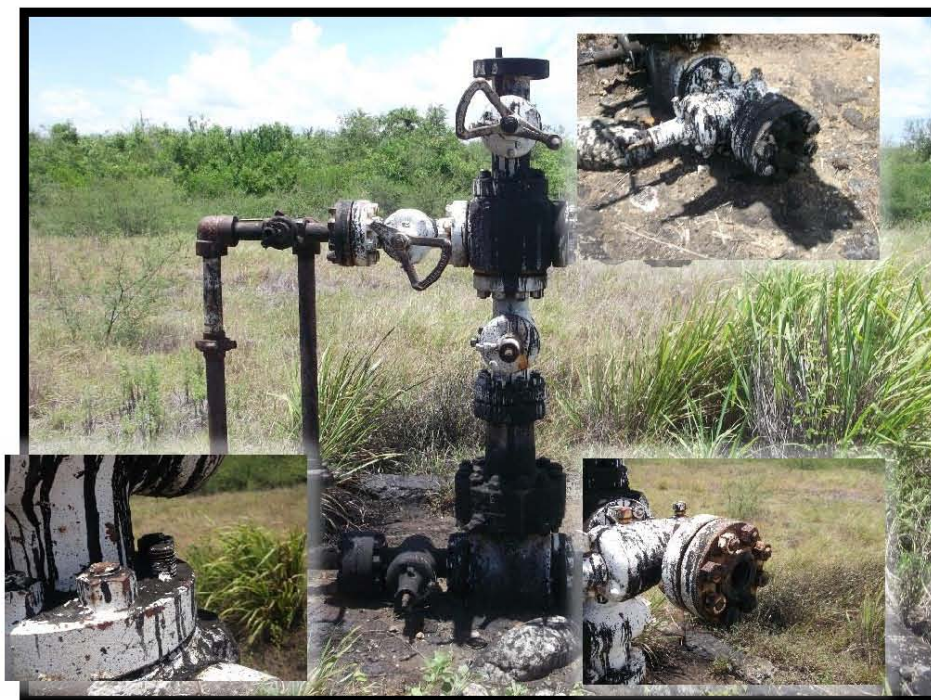
Fotografía 4.- Falta de brida ciega y capuchón en válvula de sondeo, de tapón roscado en válvula lateral derecha y en válvula de tubería de revestimiento lado derecho, falta de volantes, árbol de válvulas con manchas de hidrocarburo.
