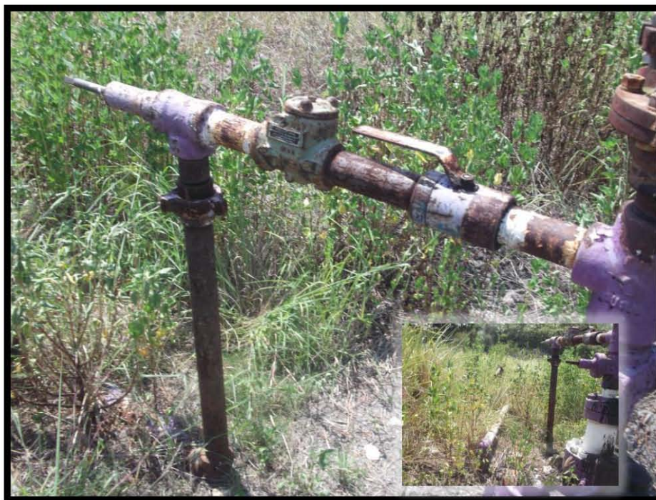
Fotografía 7.- Presencia de corrosión, falta de mochetas y abrazaderas, en bajante de producción.
