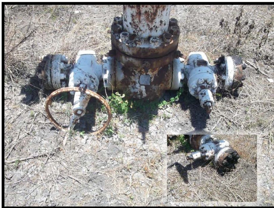
Fotografía 4.- Árbol de válvulas no cuenta con contrapozo, falta de volantes, falta de tapón roscado en válvula de tubería de revestimiento, presencia de corrosión en árbol de válvulas.
