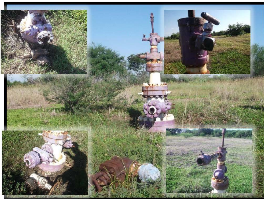
Fotografía 4.- Árbol de válvulas con corrosión y manchas de hidrocarburo, falta de barandal de protección al árbol de válvulas, de tapón roscado en válvula de tubería de revestimiento sección "a" lado izquierdo, de brida ciega en válvula de tubería de revestimiento sección "a" lado derecho, equipo de sistema artificial desconectado, falta de tapón de ½ " en válvula tipo aguja, de tapón roscado en inicio de sección de línea de recolección desconectada, falta de volantes, no cuenta con bajante de producción.
