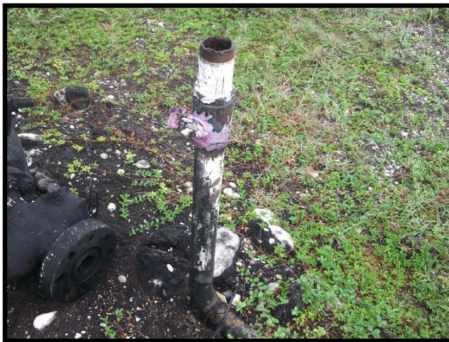
Fotografía 6.- Bajante de producción desconectada, falta de tapón roscado, corrosión y manchas de hidrocarburo.
