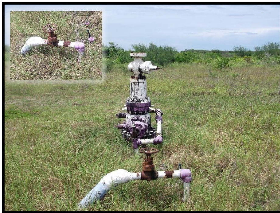
Fotografía 6.- Falta de barandal de protección a la bajante de producción, corrosión en válvula tipo globo en bajante de producción, no cuenta con mochetas y abrazaderas en bajante de producción.
