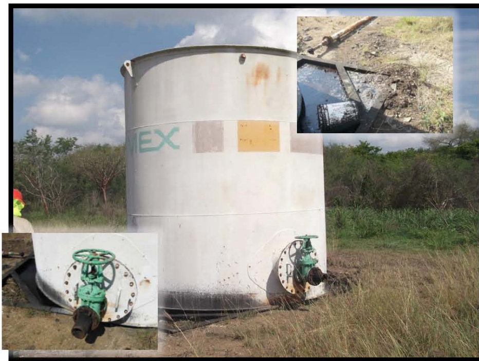
Fotografía 6.- Cuenta con tanque de boca a pozo, falta de escalera y tapón de 2" en válvula de conexión.
