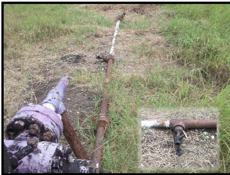
Fotografía 6.- Bajante de producción con presencia de corrosión y manchas de hidrocarburo, falta de tapón de \frac{1}{2} " en válvula tipo aguja.
