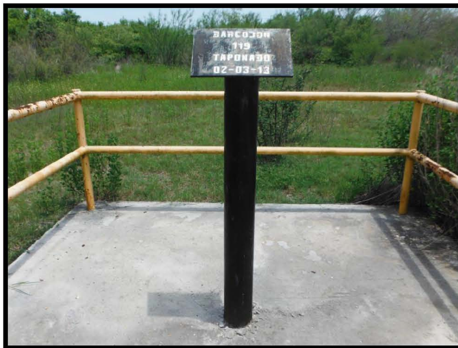
Fotografía 4.- Falta de manómetro en tubo de monumento.
