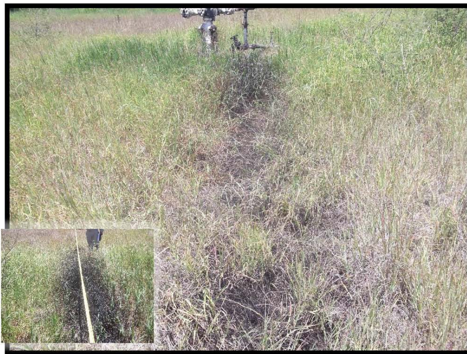
Fotografía 7.- Derrame de hidrocarburo por válvula de bajante de producción 5 m x .80 m.
