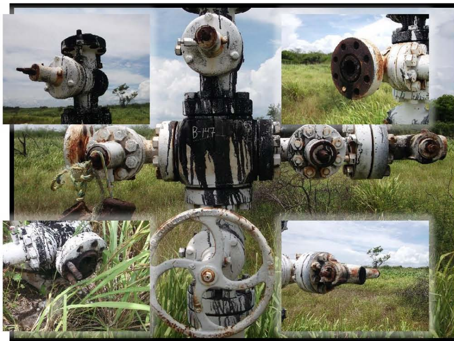
Fotografía 4.- Falta de: brida ciega, capuchón y volante en válvula de sondeo, brida ciega y volante en válvula lateral izquierda, tapón roscado en porta estrangulador, brida ciega en válvula de la tubería de revestimiento lado derecho, tapón roscado en válvula de la tubería de revestimiento lado izquierdo; árbol de válvulas con manchas de hidrocarburo, falta de barandal de protección al árbol de válvulas.
