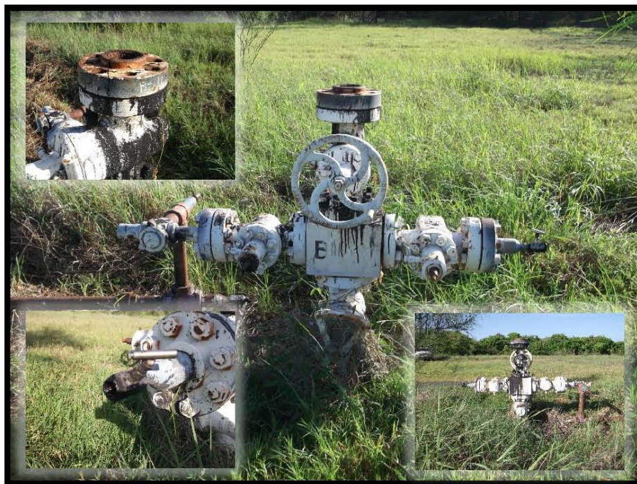
Fotografía 4.- Falta de tapón roscado y espárragos en brida de válvula de sondeo, Falta de tapones de 1/2" en válvulas tipo aguja, de volantes.
