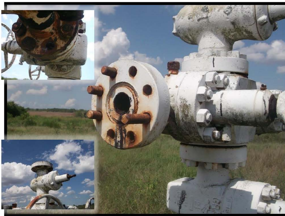
Fotografía 4.- Falta de: brida ciega y capuchón en válvula de sondeo, árbol de válvulas con corrosión y manchas de hidrocarburo, falta de barandal de protección al árbol de válvulas, de brida ciega en válvula lateral izquierda, falta de espárragos y corrosión en conexión bridada de válvula lateral izquierda con porta estrangulador.
