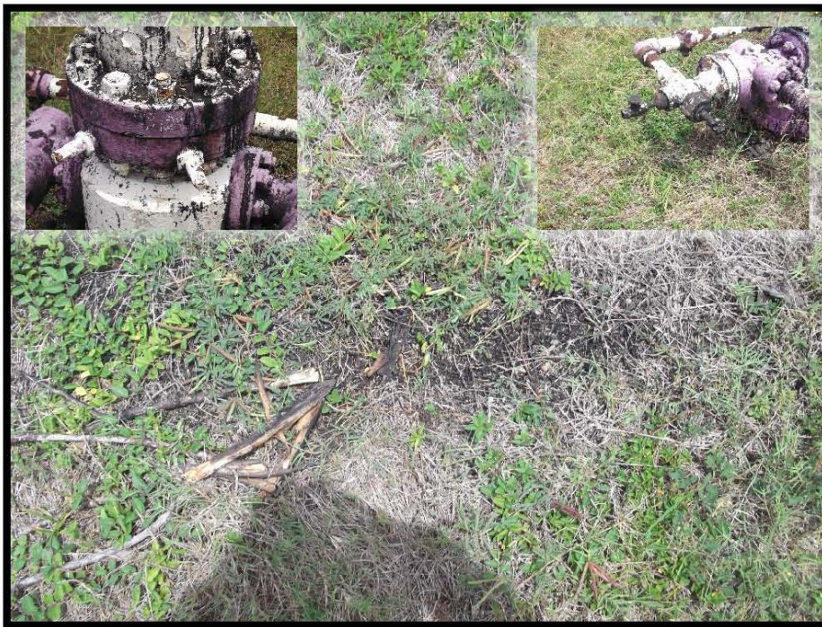
Fotografía 7.- Mancha de hidrocarburo al lado norte del árbol de válvulas, árbol de válvulas manchado.
