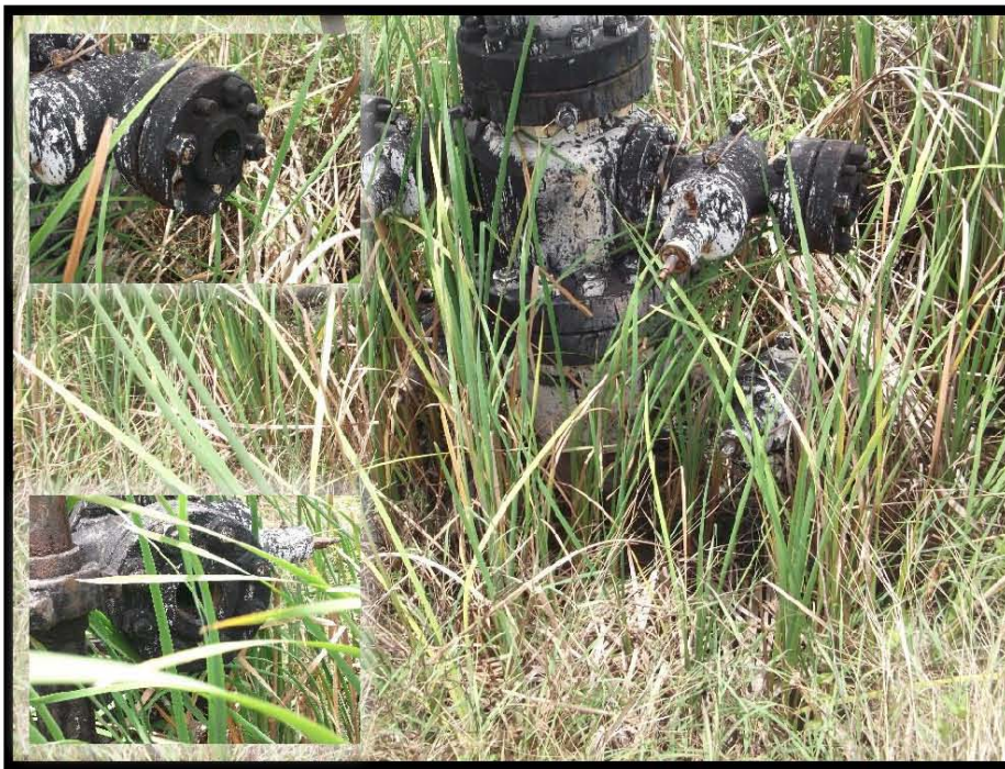
Fotografía 5.- Corrosión y manchas de hidrocarburo en cabezal del árbol de válvulas, falta de tapón roscado en válvula de tubería de revestimiento ambos lados, no cuenta con contrapozo.
