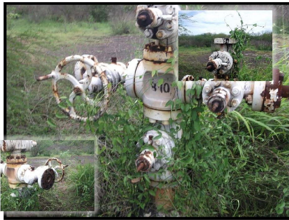
Fotografía 4.- Falta de: brida ciega y capuchón en válvula de sondeo, árbol de válvulas con corrosión, falta de volantes y de barandal de protección al árbol de válvulas, de brida ciega en válvula lateral izquierda.
