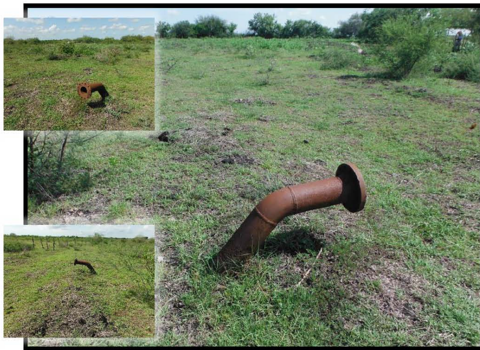
Fotografía 8.- Tubería expuesta X: 606631 Y: 2495706.
