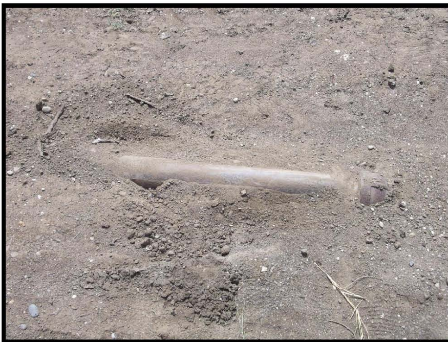
Fotografía 7.- Tubería expuesta al norte del árbol de válvulas X: 606254 Y: 2495824.
