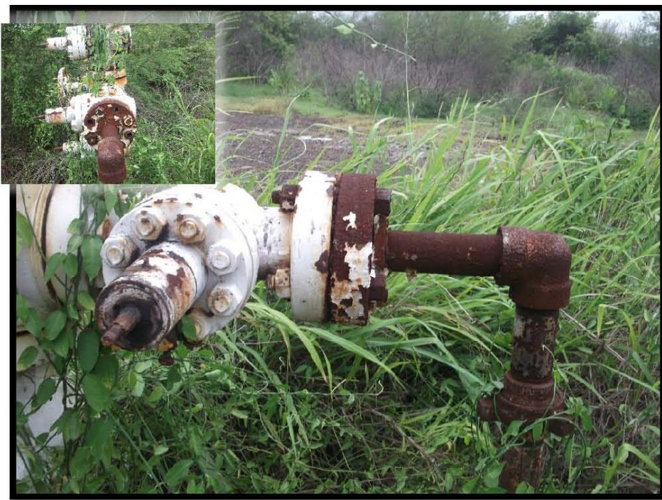
Fotografía 5.- Corrosión en bajante de producción, no cuenta con barandal de protección, falta de espárragos en conexión bridada de válvula lateral derecha con bajante de producción.
