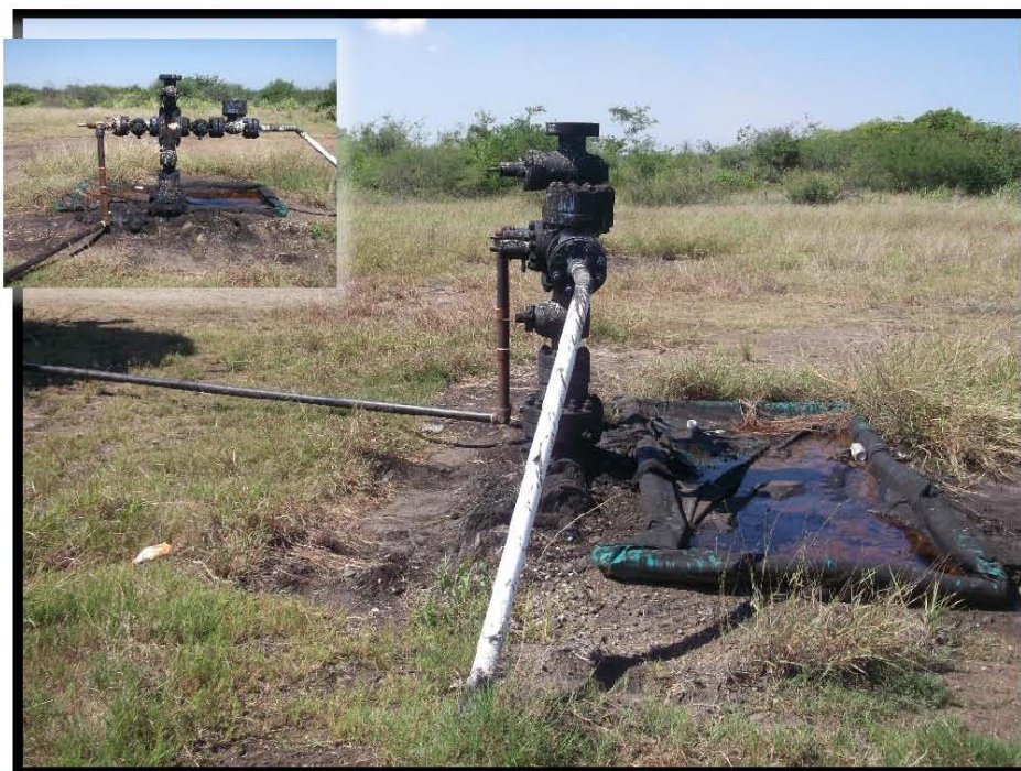
Fotografía 6.- Bajante de producción desconectada, manchas de hidrocarburo en bajante de producción.
