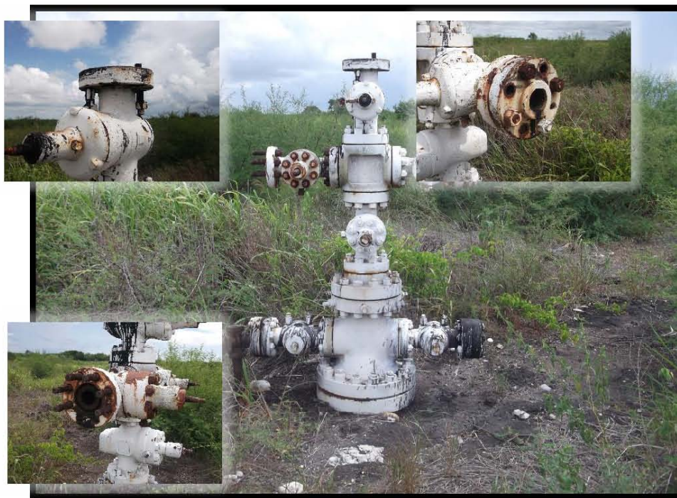
Fotografía 4.- Falta de: brida ciega y capuchón en válvula de sondeo, tapón roscado y espárragos en válvula lateral derecha, brida ciega en válvula lateral izquierda, tapones roscados en válvulas de la tubería de revestimiento; árbol de válvulas con manchas de hidrocarburo, falta de barandal de protección al árbol de válvulas.
