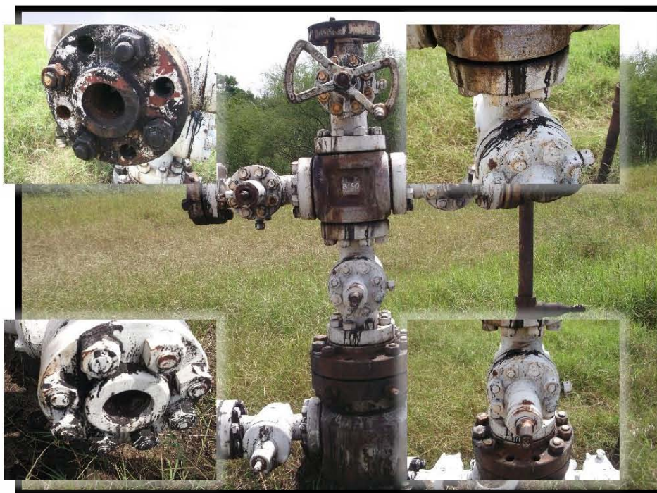
Fotografía 4.- Falta de brida ciega y capuchón en válvula de sondeo, tapón roscado y espárragos en válvula lateral izquierda, espárragos en conexión bridada del cabezal, tapones roscados en válvulas de la tubería de revestimiento sección A ambos lados, Válvulas de tubería de revestimiento sección B enterradas y tapones de ½" en válvulas tipo aguja.
