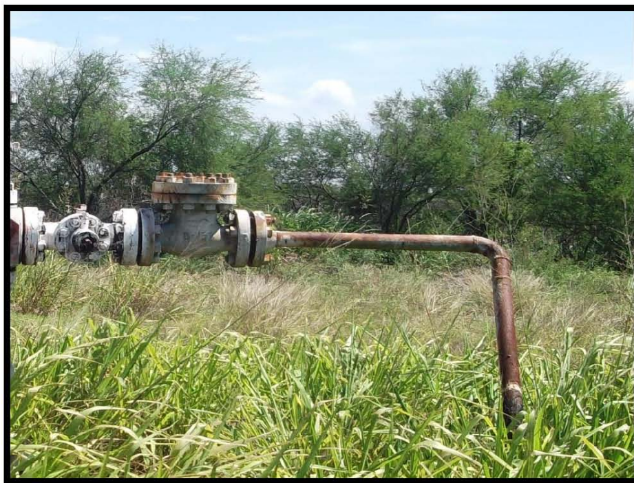
Fotografía 6.- Corrosión en bajante de producción.
