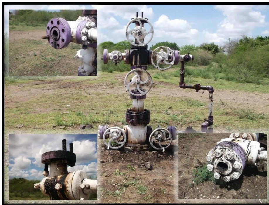
Fotografía 4.- Falta de: brida ciega y capuchón en válvula de sondeo, de brida ciega y volante en válvula lateral izquierda, de tapón roscado en válvula de tubería de revestimiento lado izquierdo, árbol de válvulas con manchas de hidrocarburo; no cuenta con barandal de protección al árbol de válvulas, falta de rotulación de nombre del Pozo.
