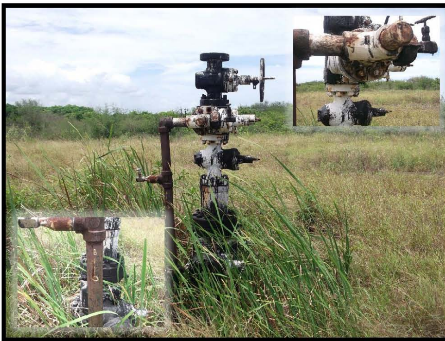
Fotografía 6. -Falta de Brandal de protección en bajante de producción, corrosión y manchas de hidrocarburo, falta de tapones de 1/2" en válvula tipo aguja de porta estrangulador y bajante de producción.
