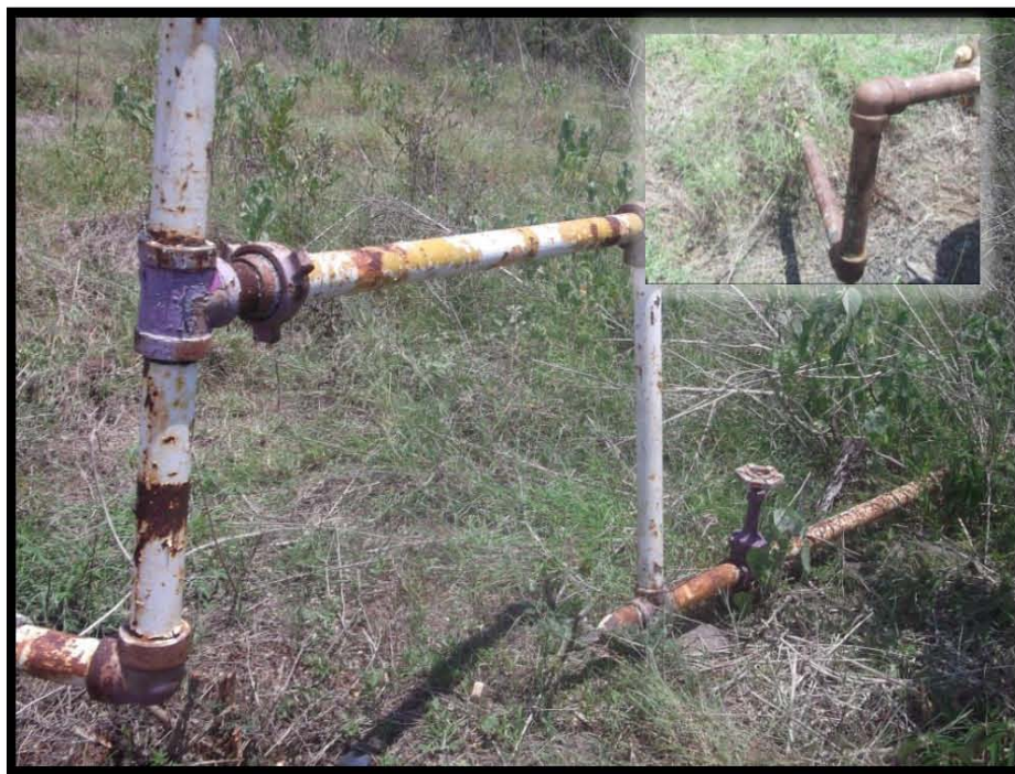
Fotografía 6.- Corrosión en conexiones roscadas, tubería de desfogue y en bajante de producción.
