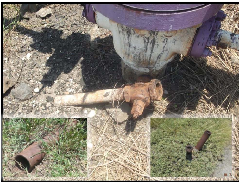
Fotografía 8.- Tuberías enterradas dentro de contrapozo y expuestas X: 605188 Y: 2497232
