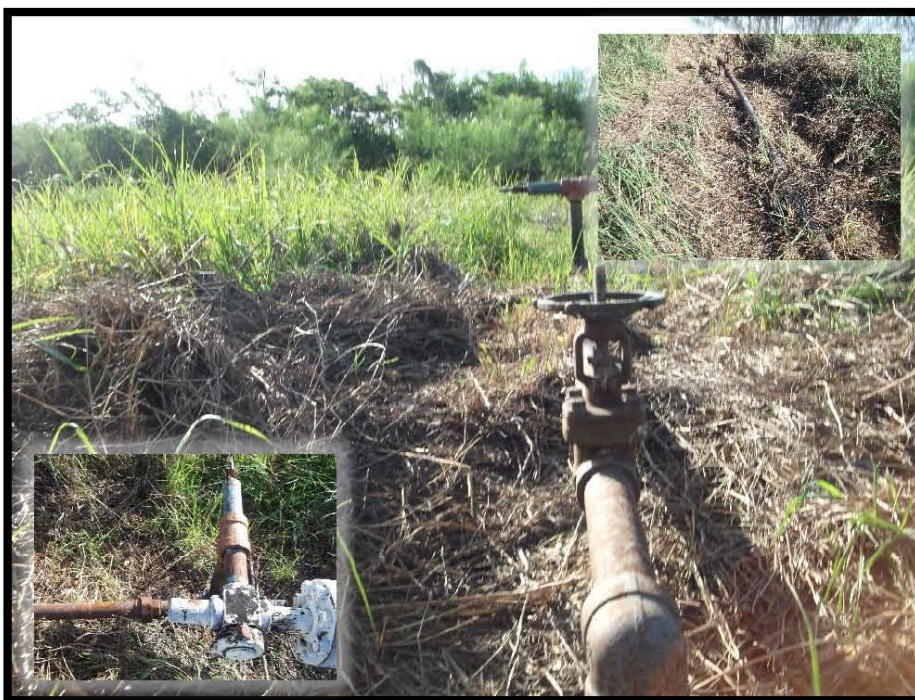
Fotografía 6.- Presencia de corrosión, falta de tapón de ½" en válvula tipo aguja en bajante de producción, falta de mochetas y abrazaderas, Derrame de hidrocarburo sobre bajante de producción, no cuenta con mochetas, abrazaderas y barandal de protección a la bajante de producción.
