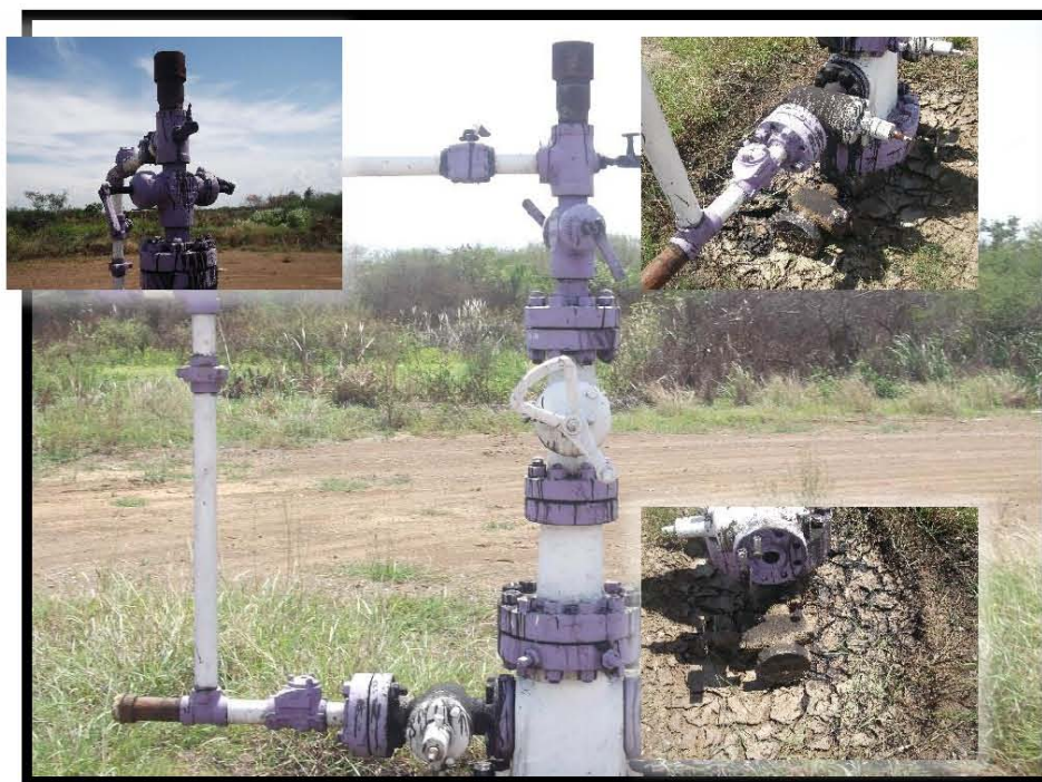
Fotografía 4.- Falta de: tapón de 1/2" en válvulas tipo aguja, brida ciega y espárragos y volante en válvula lateral derecha, bridas ciegas y volantes en válvulas de la tubería de revestimiento, espárragos en conexión bridada de la válvula lateral izquierda; árbol de válvulas con manchas de hidrocarburo, falta de barandal de protección al árbol de válvulas.
