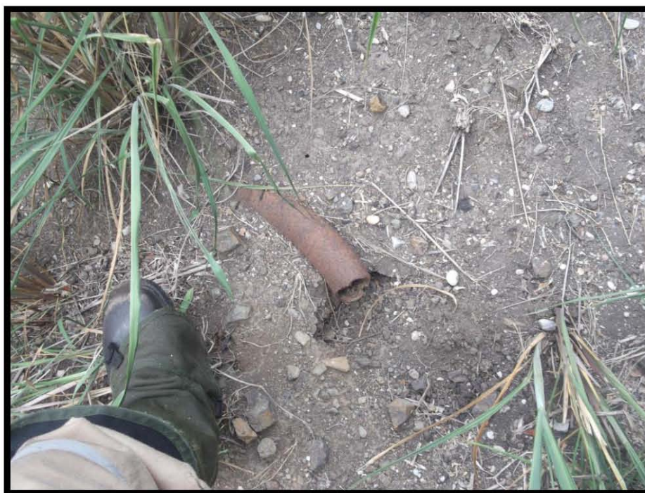
Fotografía 13.- Tubería expuesta X: 606572 Y: 2497542
