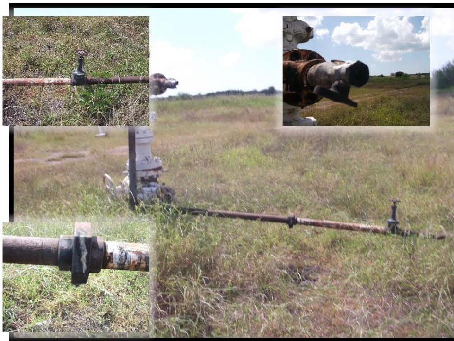
Fotografía 6.- Falta de Barandal de protección en bajante de producción, corrosión y manchas de hidrocarburo, falta de tapón de ½" en válvula tipo aguja de porta estrangulador, filtración en conexión roscada de bajante de producción.
