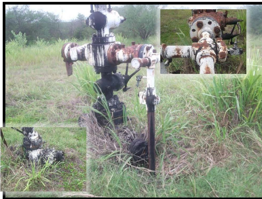
Fotografía 5.- Corrosión y manchas de hidrocarburo en bajante de producción, falta de espárragos en bridaje de válvula lateral izquierda, árbol de válvulas no cuenta con contrapozo, falta de barandal de protección en bajante de producción.
