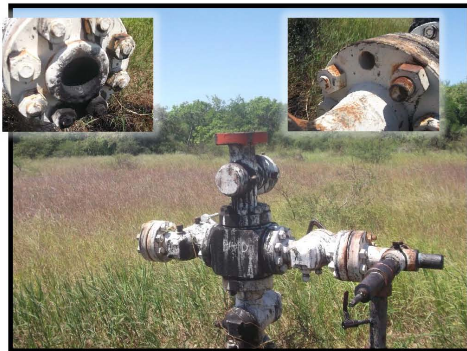
Fotografía 4.- Falta de: de brida y capuchón en válvula de sondeo, volantes, espárragos, de tapón roscado en válvula lateral derecha rotulación de nombre del pozo y barandal de protección en árbol de válvulas (manchado).
