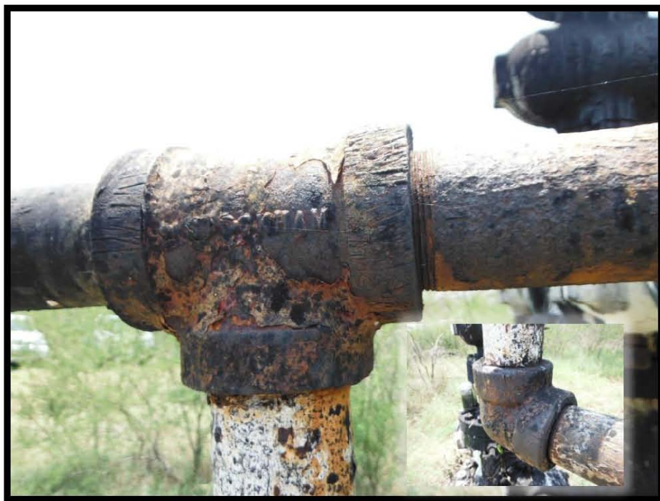
Fotografía 8.- Presenta corrosión en conexiones roscadas y bajante de producción
