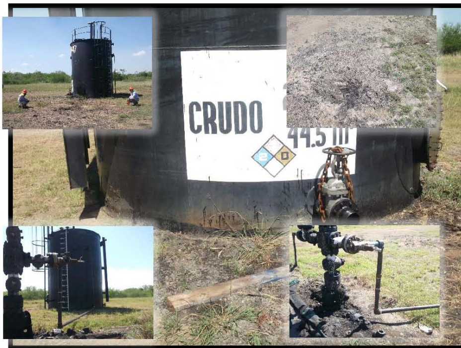
Fotografía 7.- Falta de dique de contención en tanque a boca de pozo, de puesta tierra en tanque a boca de Pozo, mochetas en LDR en tanque a boca de pozo, línea de carga del tanque cuenta con corrosión, Derrame de hidrocarburo a un costado de tanque de boca a pozo Largo: 7.50 mts. Ancho: 5.50 mts.
