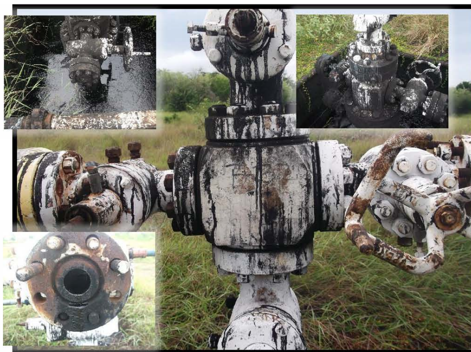
Fotografía 4.- Falta de: brida ciega, capuchón y volante en válvula de sondeo, brida ciega en válvula lateral derecha, volante en válvula lateral izquierda, tapón roscado en tubería de revestimiento, esparrago en conexión bridada válvula maestra con cabezal; filtración en válvula lateral derecha, árbol de válvulas con manchas de hidrocarburo, falta de barandal de protección al árbol de válvulas.
