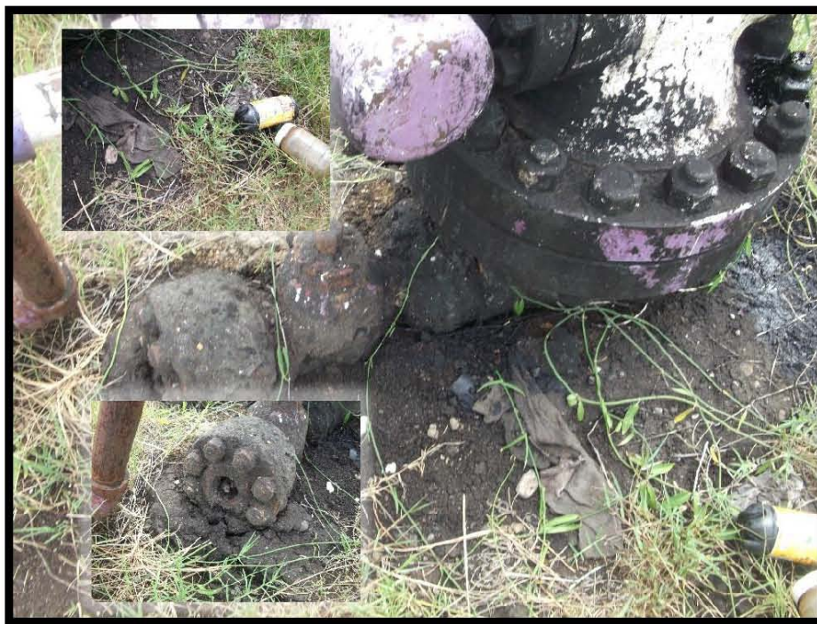
Fotografía 5.- Corrosión y manchas de hidrocarburo en cabezal del árbol de válvulas, falta de tapón roscado en válvula de tubería de revestimiento sección A lado derecho, no cuenta con contrapozo, hidrocarburo intemperizado y residuos peligrosos en periferia del árbol de válvulas.
