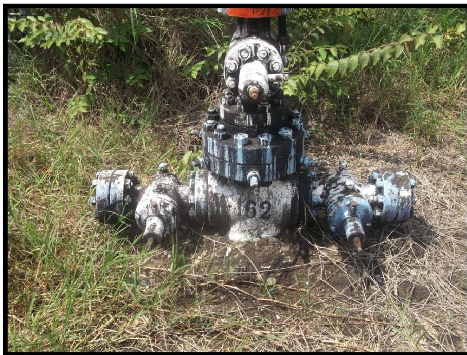
Fotografía 5.- Árbol manchado con hidrocarburo, falta de volantes.
