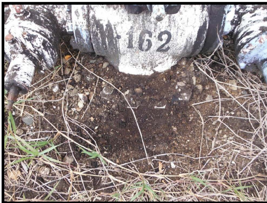
Fotografía 6.- Cabezal se encuentra tapado con tierra impregnada con hidrocarburo, no cuenta con contrapozo.
