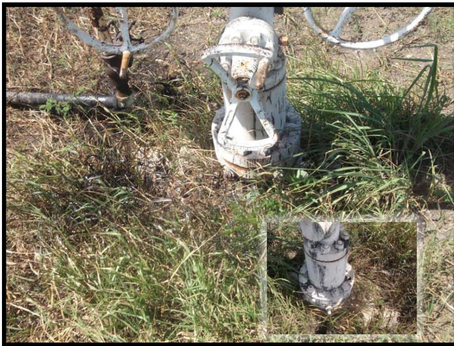
Fotografía 6.- Árbol de válvulas no cuenta con contrapozo; válvulas de tubería de revestimiento enterradas.
