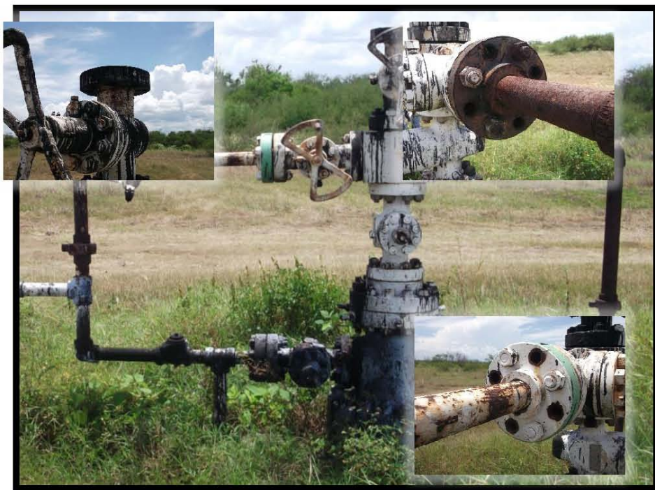
Fotografía 4.- Falta de: brida ciega y capuchón en válvula de sondeo, espárragos en válvulas laterales; árbol de válvulas con manchas de hidrocarburo, falta de barandal de protección al árbol de válvulas.
