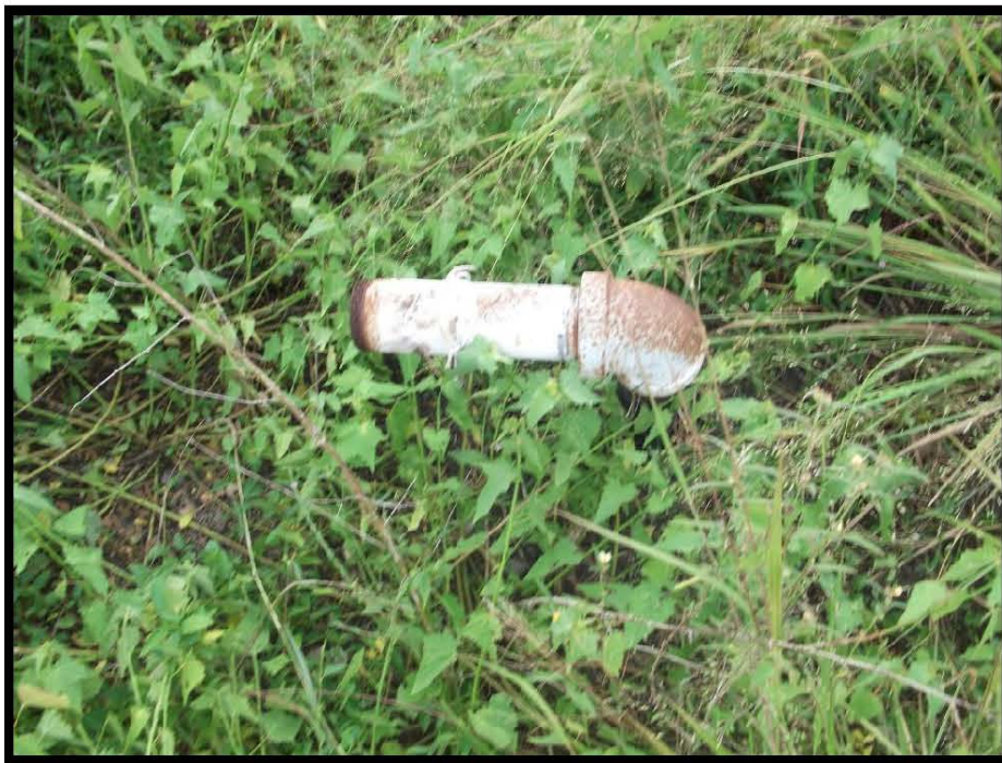
Fotografía 6.- Bajante de producción desconectada, falta de tapón roscado en inicio de sección de línea de recolección.
