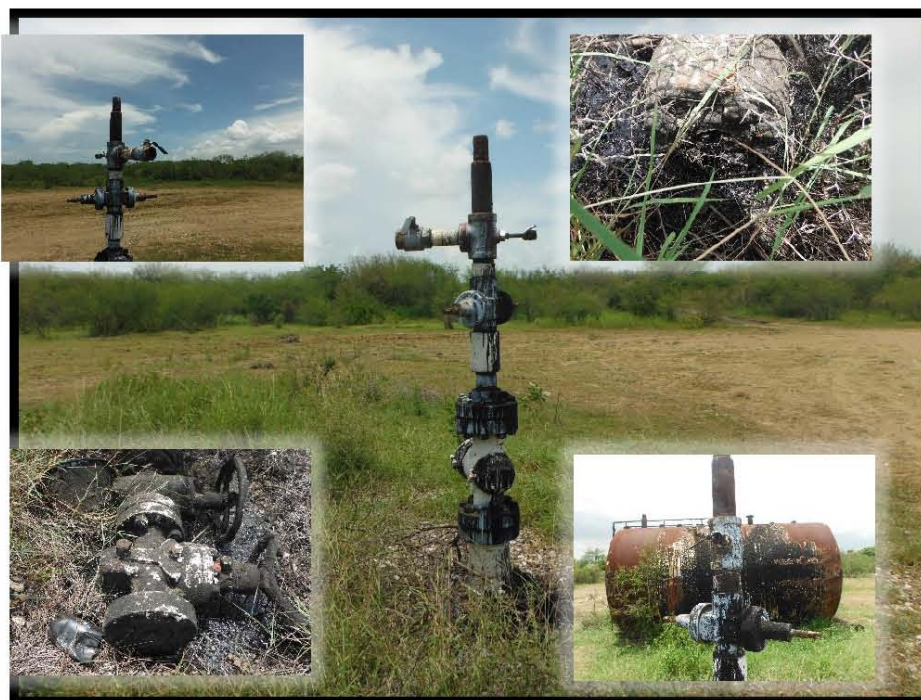
Fotografía 4.- Falta de: tapón roscado en válvula lateral derecha, brida ciega en válvula lateral izquierda, tapón de 1/2" en válvulas tipo aguja, corrosión en árbol de válvulas, árbol de válvulas con manchas de hidrocarburo.
