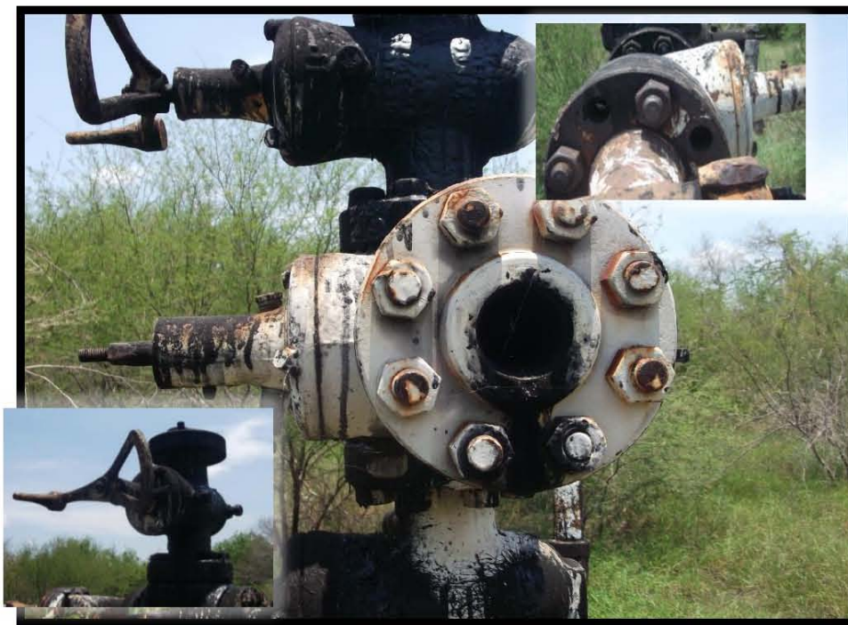
Fotografía 4.- Falta de brida y capuchón en válvula de sondeo, tapón roscado en válvula lateral derecha.
