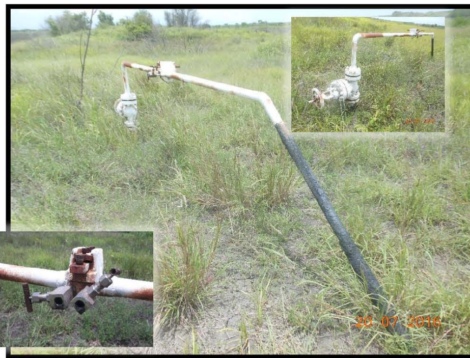
Fotografía 16.- Tubería de medición dentro del cuadro de maniobras, falta de tapones de media en válvulas tipo aguja X: 607268 Y: 2497243.
