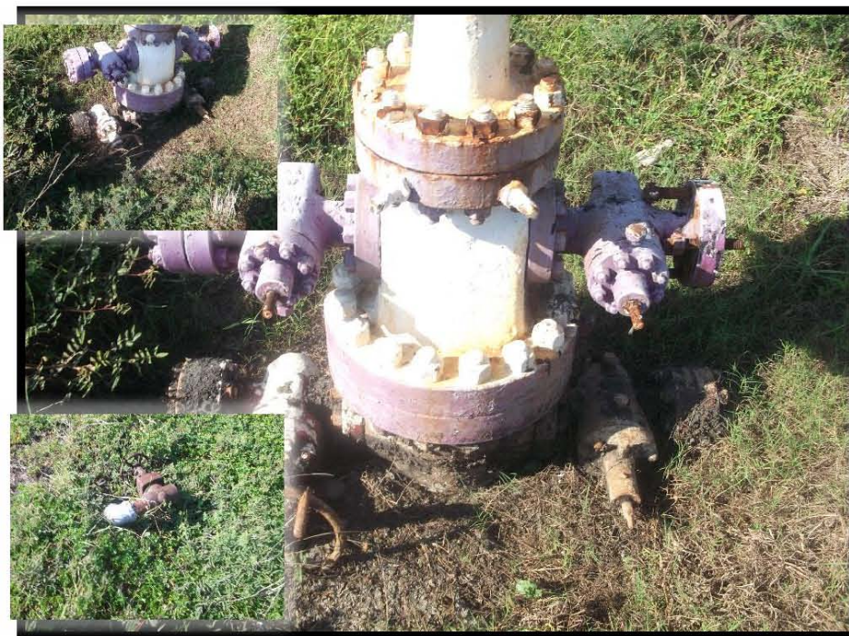
Fotografía 5.- Corrosión en cabezal del árbol de válvulas, falta de tapones roscados en válvulas de tubería de revestimiento sección B ambos lados, no cuenta con contrapozo, falta de tapón roscado en válvula globo.
