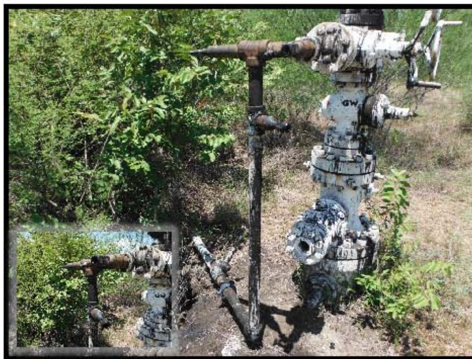
Fotografía 5.- Presencia de corrosión, falta de tapones de \frac{1}{2} " en válvulas tipo aguja, excavación a un costado del contrapozo (lado oeste), falta de mochetas y abrazaderas, de barandal de protección en bajante de producción, corrosión en porta estrangulador.
