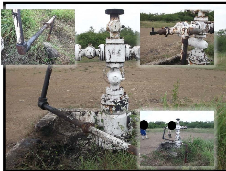
Fotografía 6.- Mancha de hidrocarburo proveniente de válvula tipo aguja en bajante de producción, falta de mochetas y abrazaderas en bajante de producción, barandal de protección en bajante de producción, Corrosión en conexiones roscadas de la bajante de producción,
