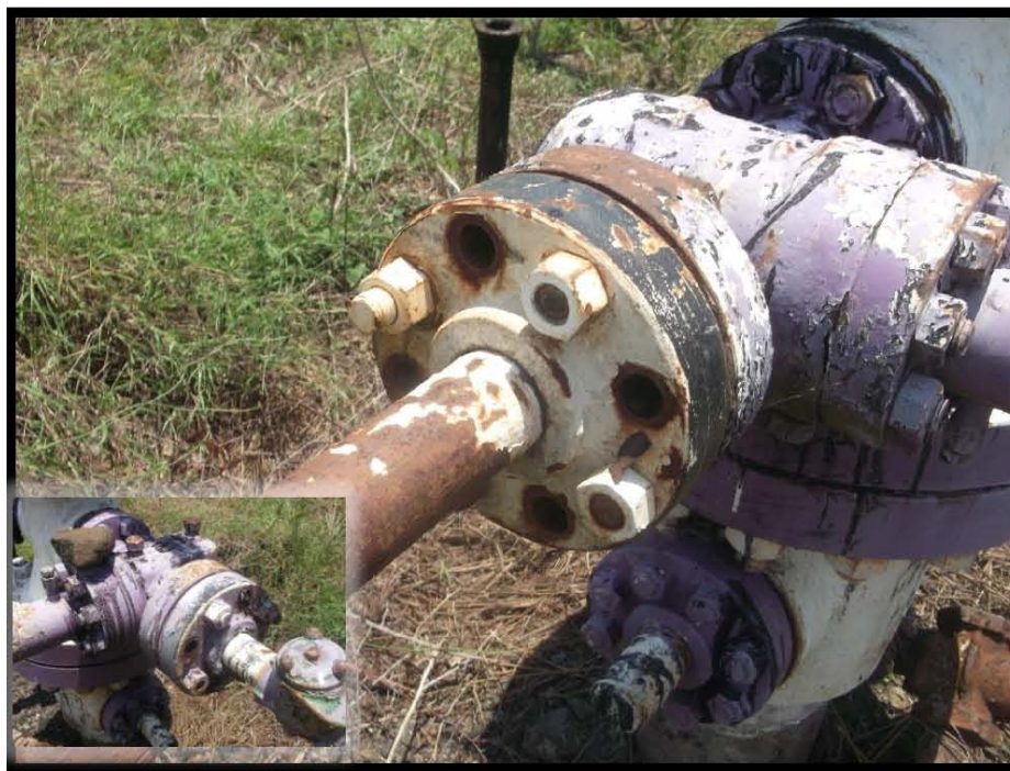
Fotografía 4.- Falta de espárragos brida de válvula lateral izquierda y derecha.
