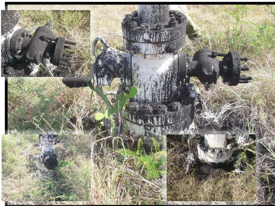
Fotografía 5.- Corrosión y manchas de hidrocarburo en cabezal del árbol de válvulas, falta de tapón roscado en válvula de tubería de revestimiento sección A lado derecho, de brida ciega en válvula de tubería de revestimiento sección A lado izquierdo, sección B de las válvulas de tubería de revestimiento se encuentran enterradas, no cuenta con contrapozo, falta de volantes.
