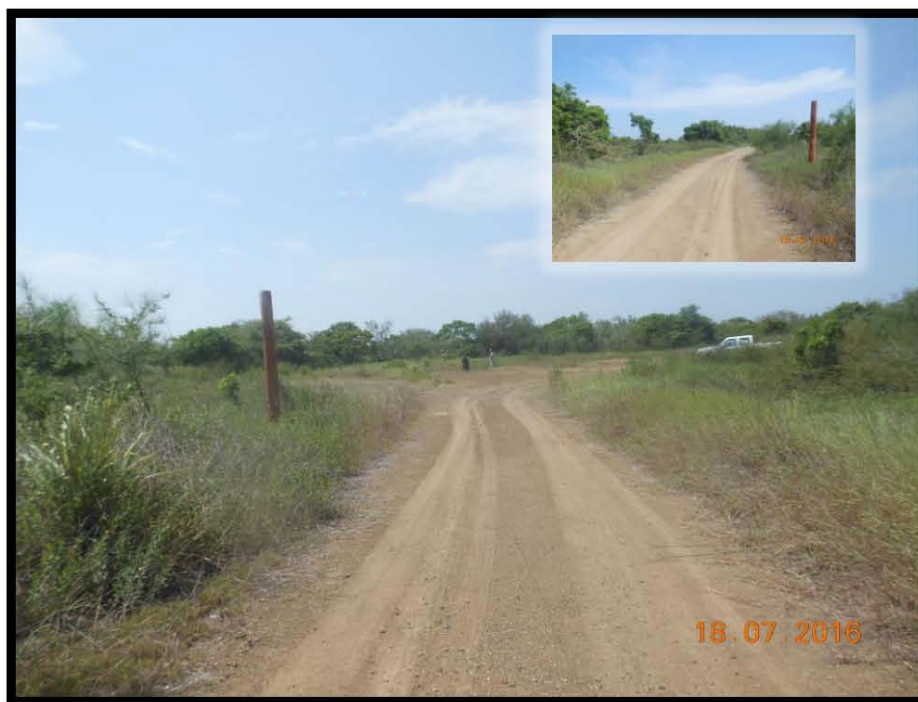
Fotografía 2.- No cuenta con guardaganado, portón de acceso, con señalamientos en acceso al Pozo, falta de señalización de límite de velocidad en camino de acceso.
