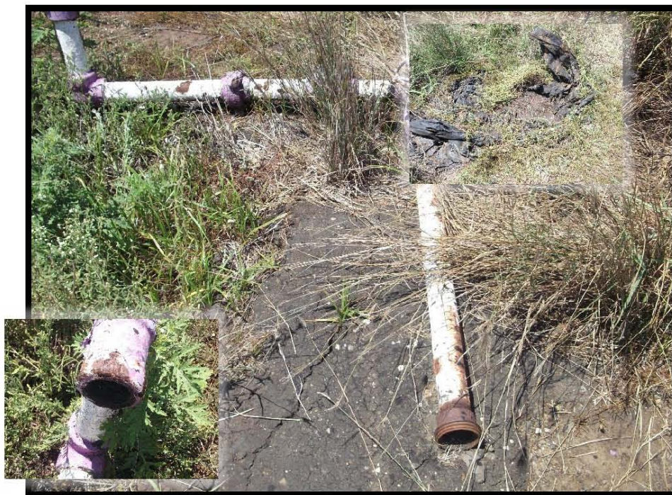
Fotografía 6.- Falta de tapones roscados en bajante de producción, corrosión, residuo peligroso a un costado (trapo impregnado con hidrocarburo).
