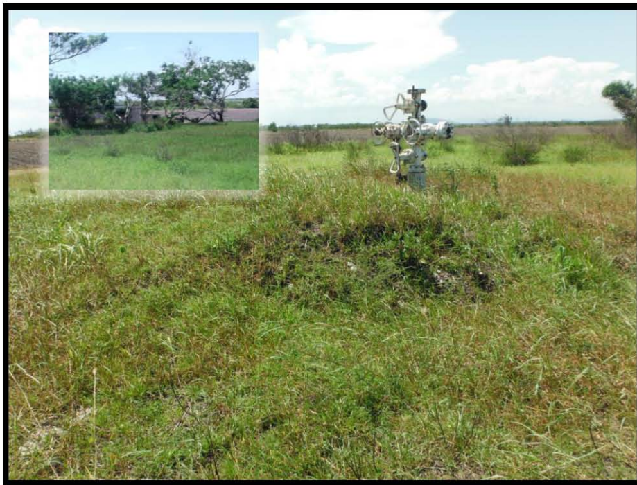
Fotografía 3.- Vista general del cuadro de maniobras, falta de mantenimiento y cercado perimetral, vegetación dentro del cuadro de maniobras, montículo de material en periferia del árbol de válvulas.
