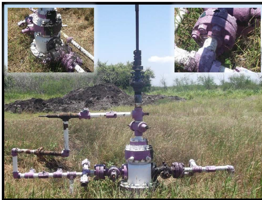
Fotografía 4.- Preparación para bombeo mecánico, falta de volantes, de espárragos, falta de rotulación de nombre del pozo, no cuenta con barandal de protección al árbol de válvulas(manchado).
