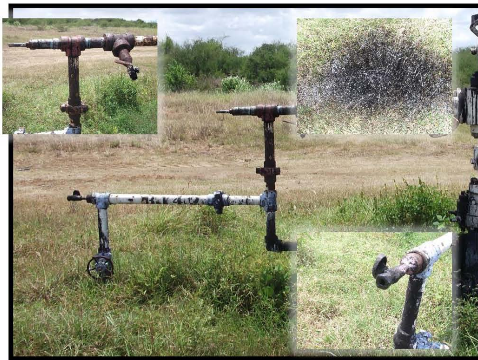
Fotografía 6.- Presencia de corrosión, falta de tapones de 1/2" en válvulas tipo aguja, mancha de hidrocarburo sobre bajante de producción, no cuenta con mochetas, abrazaderas y barandal de protección a la bajante de producción.
