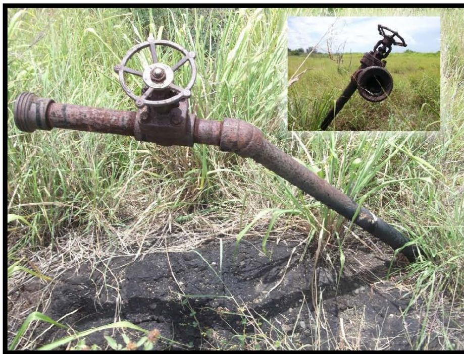
Fotografía 6.- Presencia de corrosión, falta de tapón en inicio de sección de línea de recolección, mancha de hidrocarburo sobre bajante de producción, no cuenta con mochetas, abrazaderas y barandal de protección a la bajante de producción.
