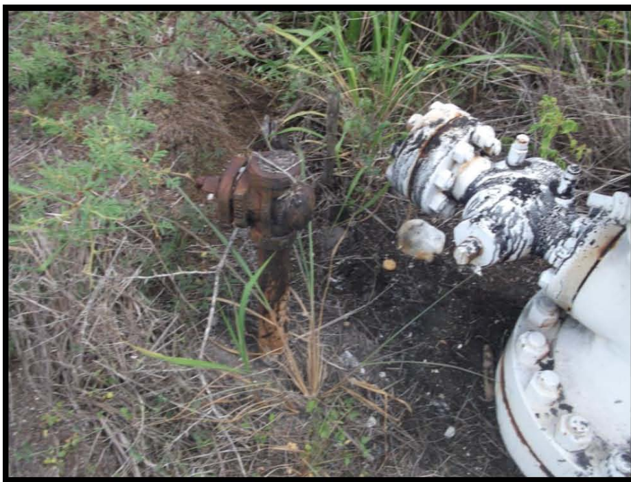
Fotografía 6.- Bajante de producción desconectada, falta tapón roscado en inicio de línea de recolección.
