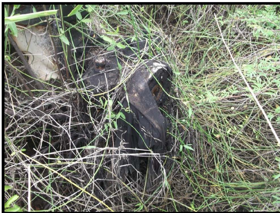
Fotografía 6.- No cuenta con contrapozo, hidrocarburo intemperizado en periferia del árbol de válvulas, falta de brida ciega en válvula de tubería de revestimiento lado derecho.
