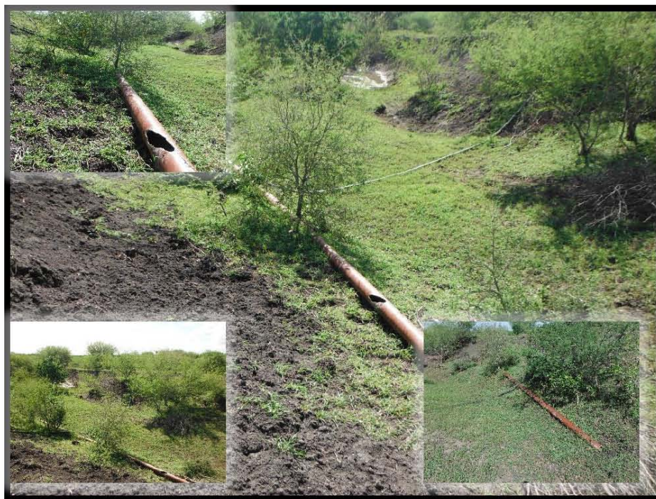
Fotografía 9.- Dentro de Esguerrimiento de agua intermitente tubería expuesta de fibra de vidrio X- 606627 Y- 2495499
