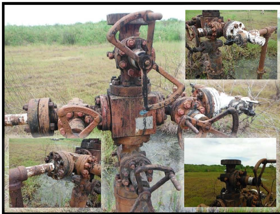
Fotografía 4.- Falta de: brida ciega y capuchón en válvula de sondeo, árbol de válvulas con corrosión y manchas de hidrocarburo, de barandal de protección al árbol de válvulas, falta de espárragos en conexión bridada de válvula lateral izquierda y derecha.
