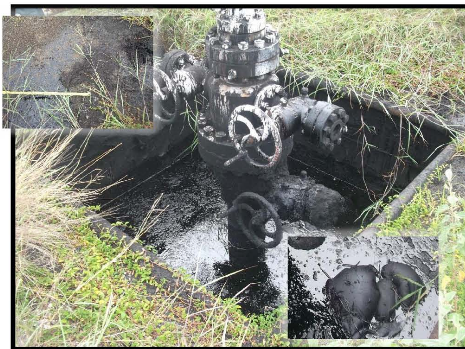
Fotografía 5.- Contrapozo de metal con hidrocarburo a un 40%, no cuenta con rejilla tipo Irving, residuos peligrosos dentro y a un costado del contrapozo y derrame de hidrocarburo en la periferia.
