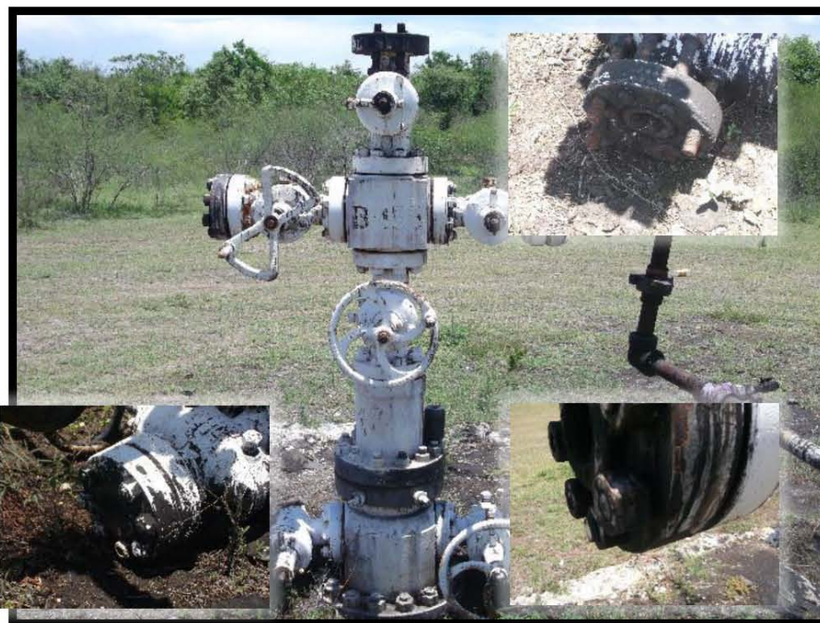
Fotografía 4.- Falta de brida ciega y capuchón en válvula de sondeo, de tapón roscado en válvula lateral izquierda, de brida ciega en válvula de tubería de revestimiento lado izquierdo, falta de tapón roscado en válvula de tubería de revestimiento lado derecho, árbol de válvulas con manchas de hidrocarburo y corrosión, falta de volantes y de barandal de protección.
