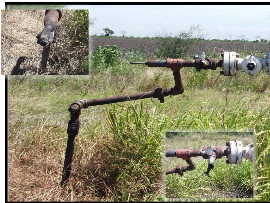
Fotografía 5.- Corrosión y manchas de hidrocarburo en bajante de producción, falta de tapones de ½ " en válvulas tipo aguja, no cuenta con barandal de protección.
