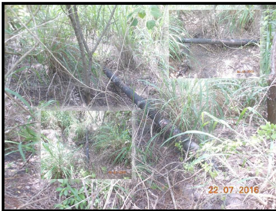
Fotografía 6.- Tubería expuesta al Sur del cuadro de maniobras X: 605930 Y: 2496402
