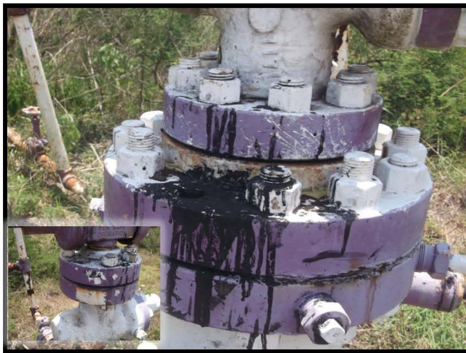
Fotografía 5.- Falta de espárragos en conexión bridada y en válvula de sondeo.
