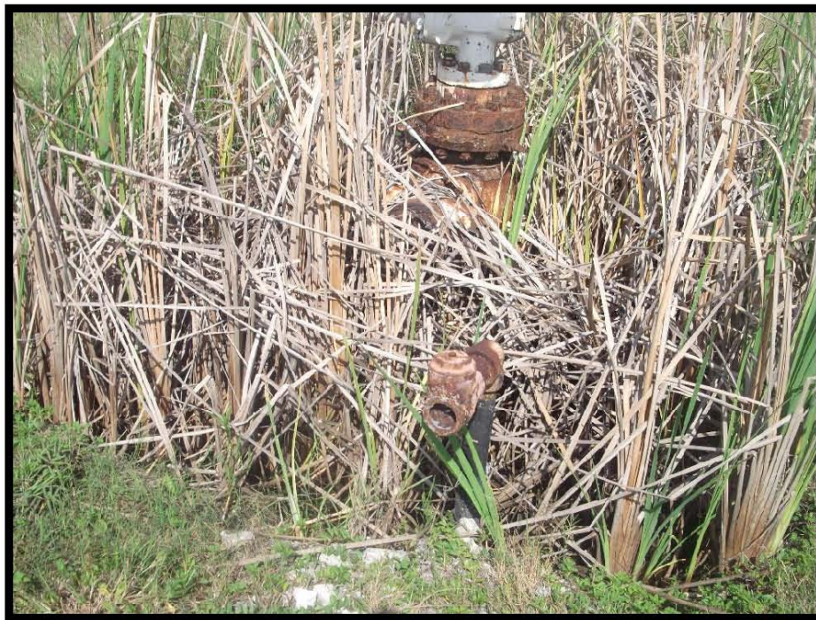
Fotografía 6.- Presencia de corrosión, falta de tapón roscado, tubería expuesta, falta de mochetas y abrazaderas, de barandal de protección en bajante de producción.
