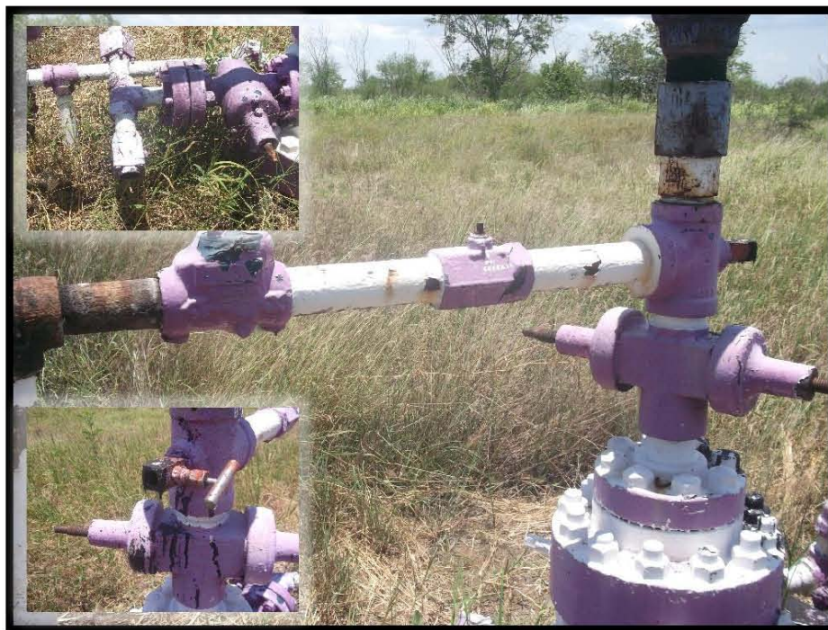
Fotografía 6.- Presencia de corrosión, falta de tapón roscado de 1/2" en válvula tipo aguja, tapón roscado en bajante de producción, falta de mochetas y abrazaderas
