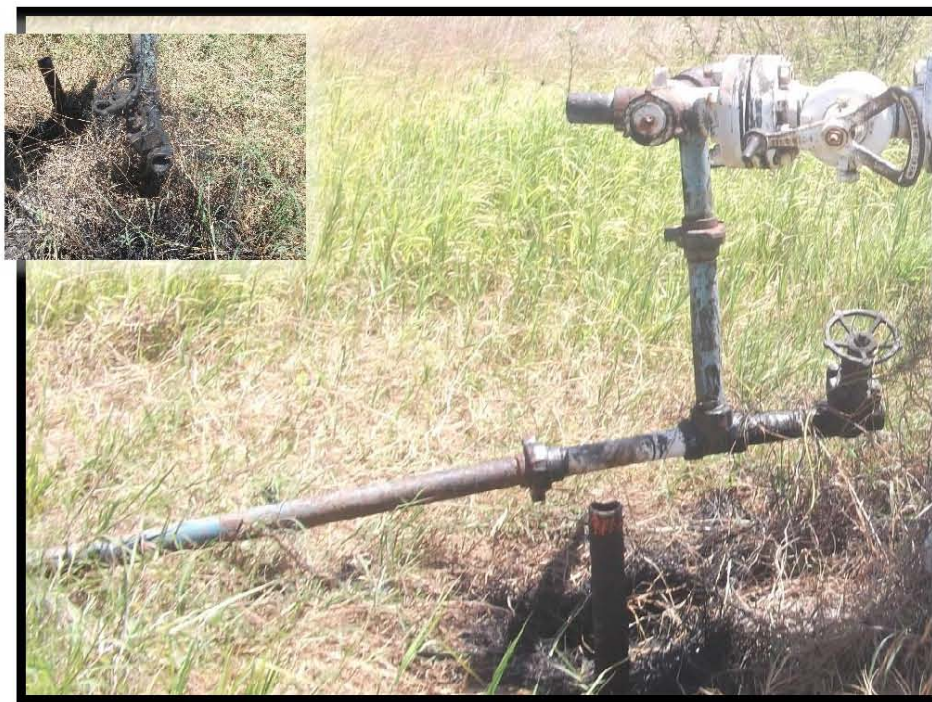
Fotografía 6.- Presencia de corrosión, falta de tapón roscado en válvula tipo globo, tubería expuesta, falta de mochetas y abrazaderas, de barandal de protección en bajante de producción.
