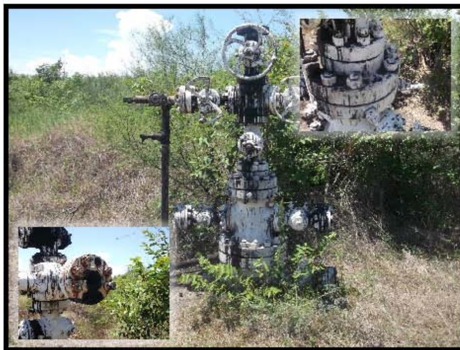
Fotografía 3.- Falta de: de brida y capuchón en válvula de sondeo, volantes, espárragos, de tapón roscado en válvula lateral derecha rotulación de nombre del Pozo y barandal de protección en árbol de válvulas (manchado).
