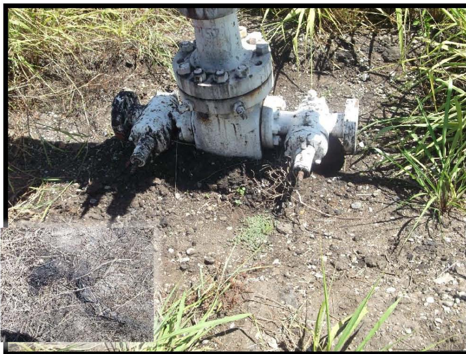
Fotografía 7.- No cuenta con contrapozo, hidrocarburo intemperizado en la periferia del árbol de válvulas.
