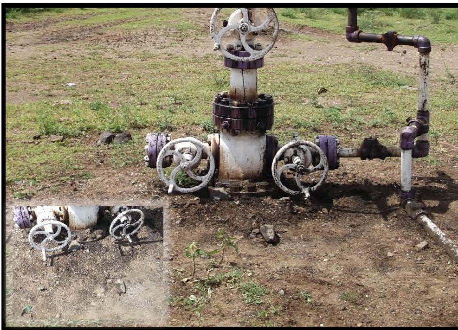
Fotografía 6.- No cuenta con contrapozo, hidrocarburo intemperizado en periferia del árbol de válvulas.
