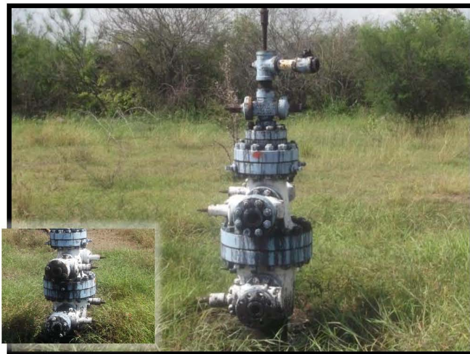
Fotografía 3.- Falta de tapón roscado de 2" en válvulas laterales, conexión tipo "t" de válvula de sondeo y en cabezal de tubería de revestimiento sección A.
