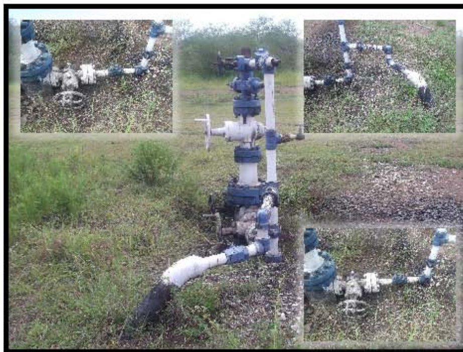
Fotografía 5.- No cuenta con barandal de protección a bajante de producción, falta de abrazaderas y mochetas en bajante de producción.
