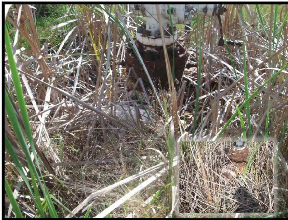
Fotografía 5.- Árbol de válvulas no cuenta con contrapozo, falta de bridas ciegas y tapones roscados en válvulas de tubería de revestimiento.
