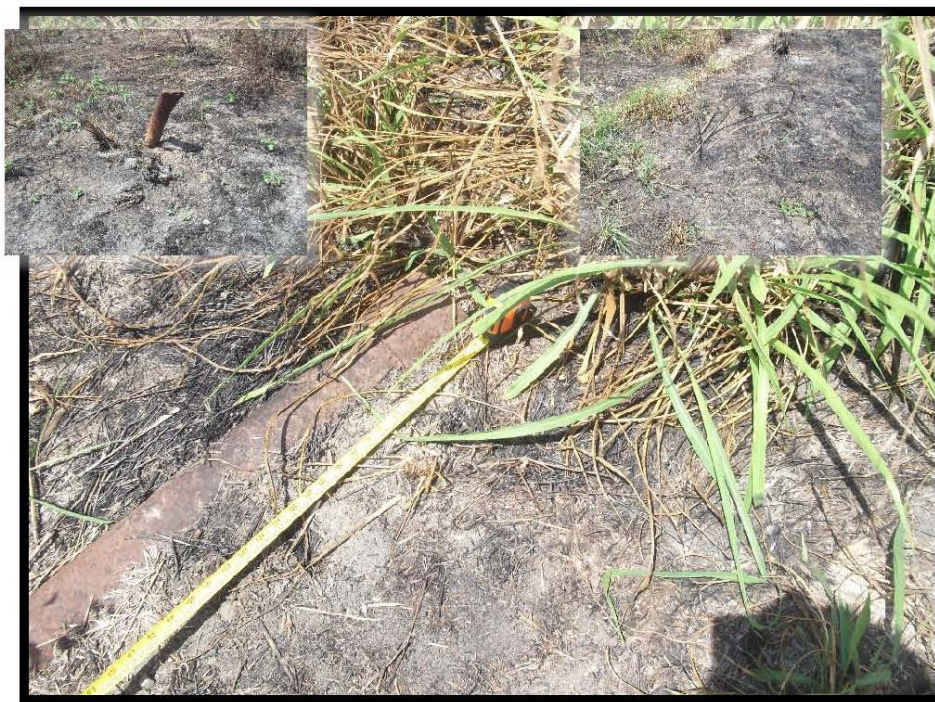
Fotografía 14.- Tubería expuesta X: 606985 Y: 2496588 3.10 m Anclaje: X: 606977 Y: 2496592
