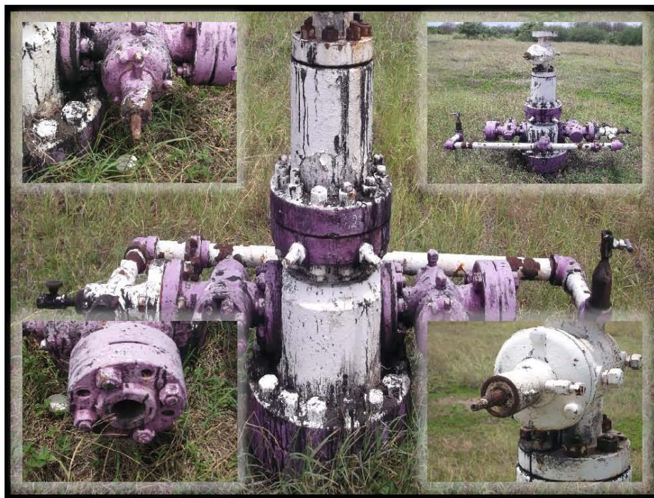
Fotografía 4.- falta de brida ciega y capuchón en válvula de sondeo, tapón roscado y espárragos en conexión bridada de válvula lateral derecha, espárragos en árbol de válvulas, tapón de 1/2" en válvulas tipo aguja, corrosión en árbol de válvulas.
