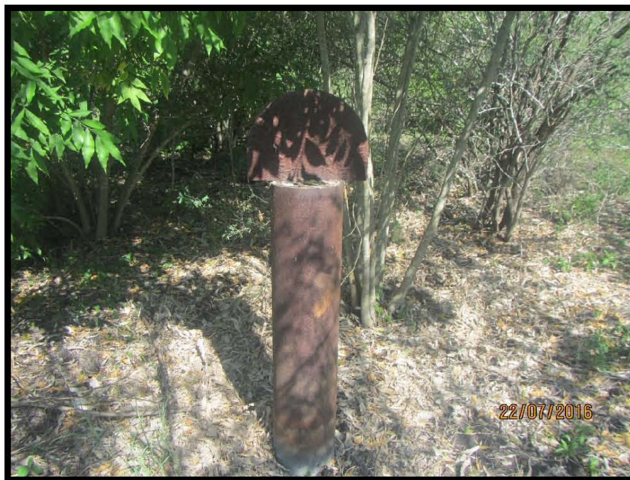
Fotografía 2.- No cuenta con camino de acceso al Pozo, no cuenta con barandal de protección al Pozo, plancha de concreto y manómetro.
