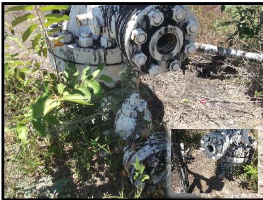
Fotografía 4.- Árbol de válvulas no cuenta con contrapozo, falta de volantes, falta de tapones roscado en válvula de tubería de revestimiento.
