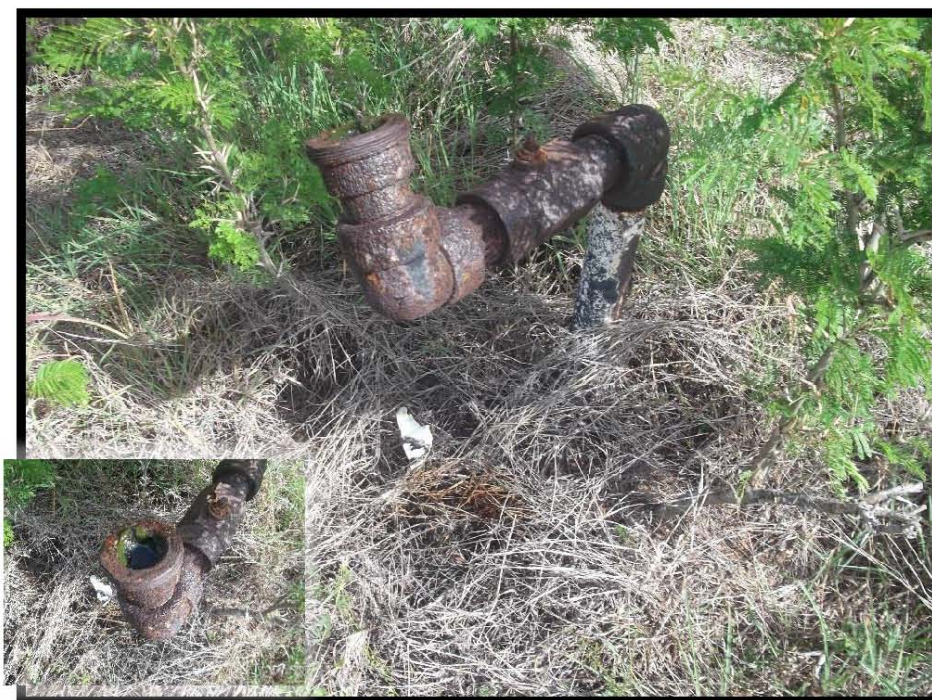
Fotografía 6.- Tubería expuesta con derrame de hidrocarburo X-606586, Y-2498748.
