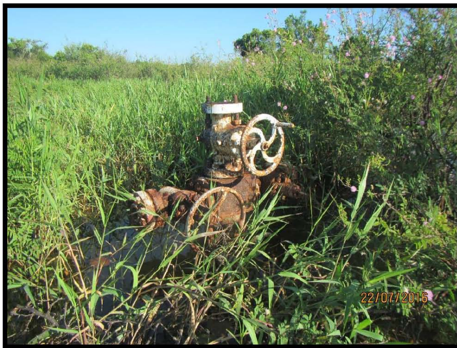
Fotografía 5.- Falta de volantes en árbol de válvulas.
