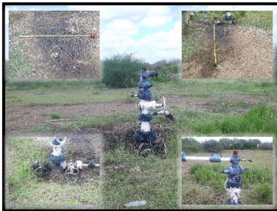
Fotografía 6.- Mancha de hidrocarburo en periferia del contrapozo de 2.80 x 1.20m, falta de barandal de protección del pozo, No cuenta con contrapozo, falta de volantes, en árbol de válvulas.
