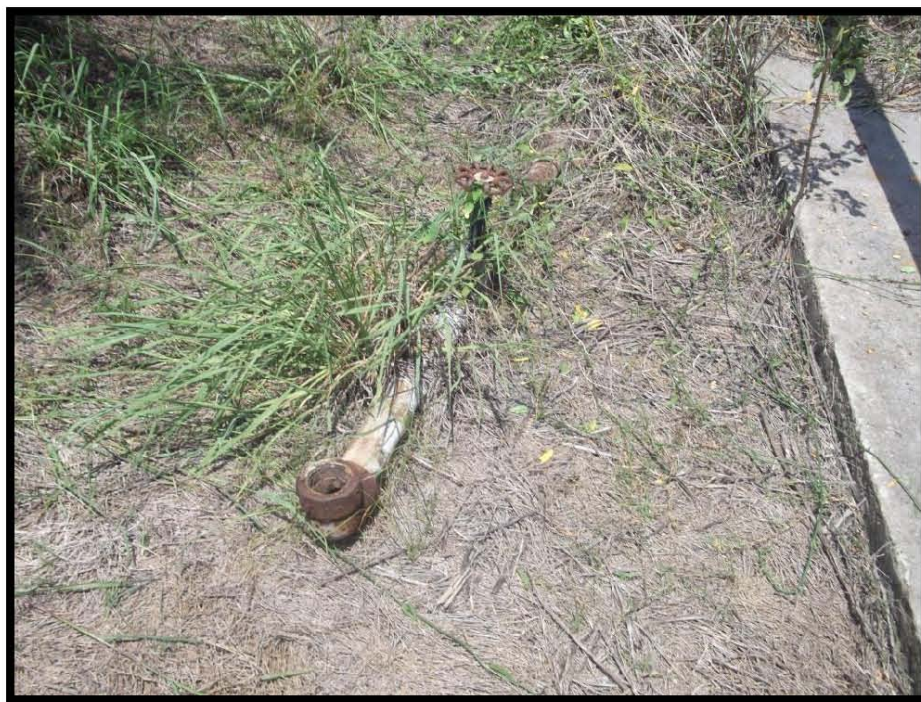
Fotografía 5.- Tubería de línea de recolección expuesta (a un costado del pozo).
