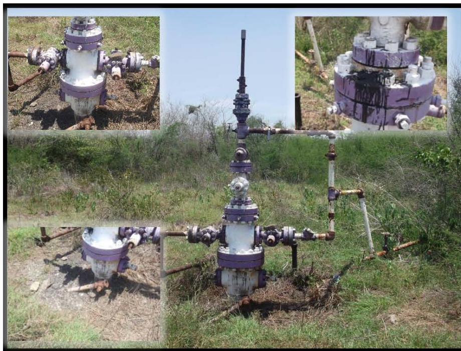
Fotografía 7.- Falta de mantenimiento y volantes al árbol de válvulas, contrapozo azolvado, árbol de válvulas manchado de hidrocarburo.
