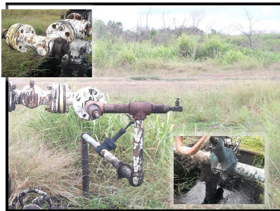
Fotografía 6.- Presencia de corrosión, falta de tapón de 1/2" en válvula tipo aguja, filtración en válvula tipo globo, mancha de hidrocarburo sobre bajante de producción, no cuenta con mochetas, abrazaderas y barandal de protección a la bajante de producción.
