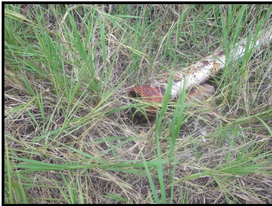
Fotografía 8. - Bajante de producción desconectada del árbol de válvulas sin tapón roscado de 3".
