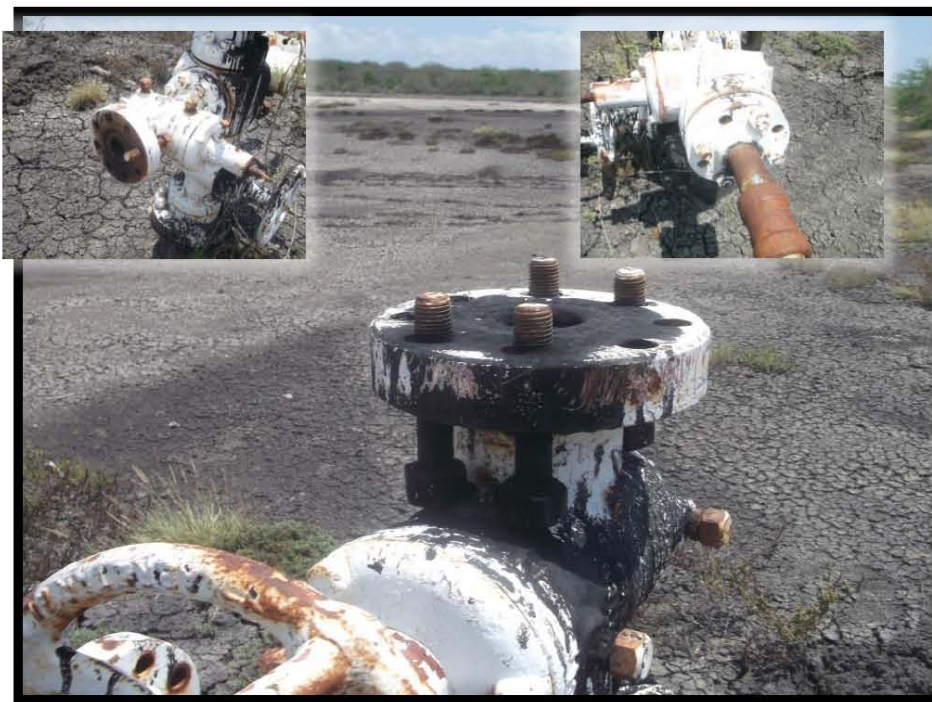
Fotografía 5.- Falta de brida ciega, capuchón y espárragos en válvula de sondeo y válvulas laterales.
