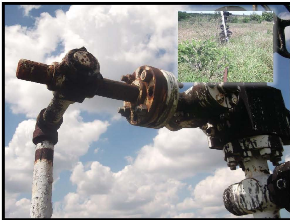
Fotografía 6.- Presencia de corrosión, falta de espárragos, abrazaderas y barandal de protección en bajante de producción.
