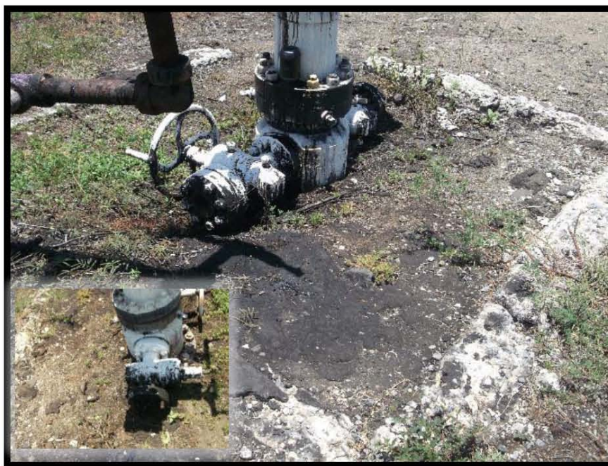
Fotografía 6.- Contrapozo azolvado, hidrocarburo intemperizado en periferia del árbol de válvulas, manchas de hidrocarburo en cabezal.
