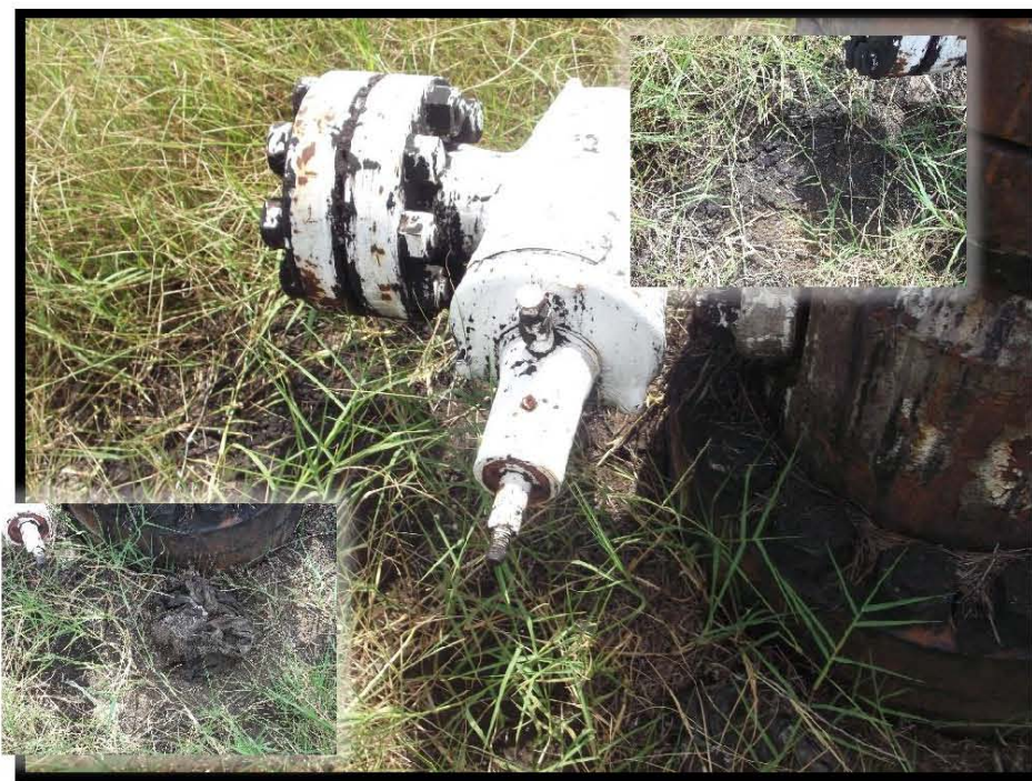
Fotografía 5.- No cuenta con contra pozo, no cuenta con rejilla Irving, hidrocarburo intemperizado en periferia del árbol de válvulas, residuo peligroso a un costado del árbol de válvulas.
