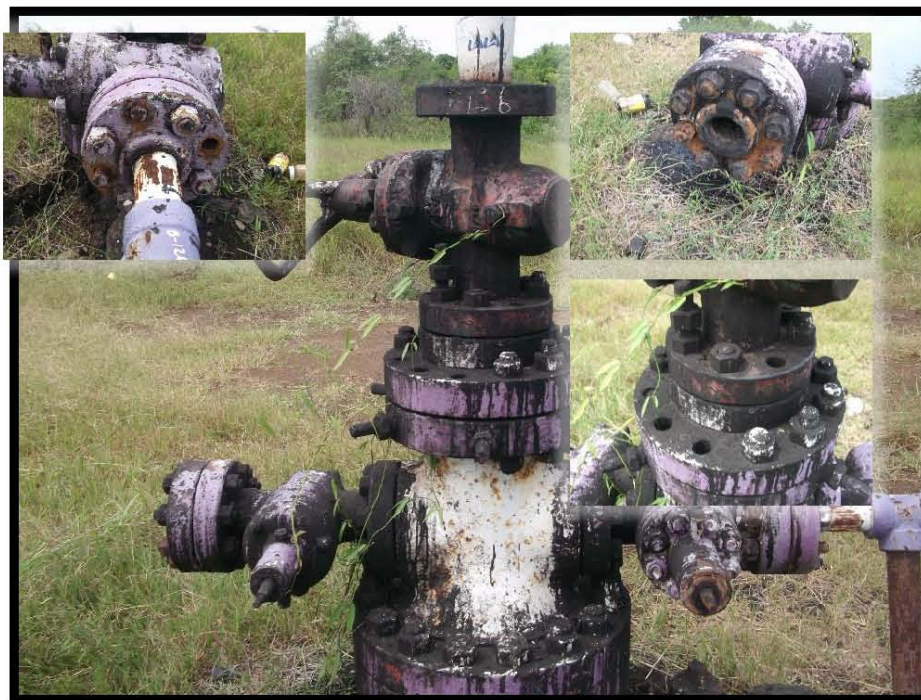
Fotografía 4.- Falta de: brida ciega y capuchón en válvula de sondeo, árbol de válvulas con corrosión y manchas de hidrocarburo, falta de volantes, de barandal de protección al árbol de válvulas, de espárragos en conexión bridada de válvula lateral derecha, de tapón roscado en válvula lateral izquierda, residuo peligroso sobre la válvula de sondeo (recipiente de plástico).
