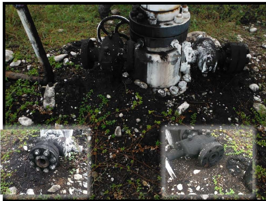
Fotografía 5.- Corrosión y manchas de hidrocarburo en cabezal del árbol de válvulas, falta de espárragos en conexión bridada del cabezal, de tapón roscado en válvula de tubería de revestimiento sección A lado izquierdo, de brida ciega en válvula de tubería de revestimiento sección A lado derecho, no cuenta con contrapozo, hidrocarburo intemperizado en periferia del árbol de válvulas.
